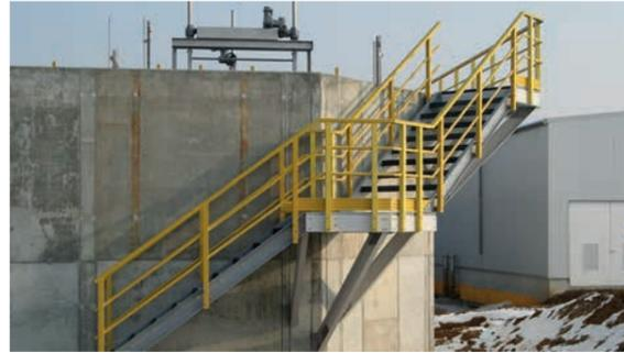
GFK-Gitterroststufen können im Antrittsbereich mit einem schwarz besandeten Flachmaterial oder zur statischen Verstärkung, mit einem Antrittswinkel ausgeführt werden. Standardmäßig werden die GFK-Stufen ohne Seitenplatten geliefert, können aber optional mit einer, aus einem GFK-Winkel gefertigten, Seitenplatte verschraubt werden.
