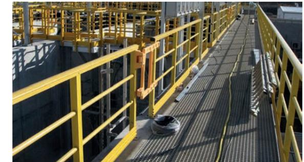
GFK-Podeste/Laufgänge werden komplett aus GFK nach anerkannten Regeln und Vorschriften gefertigt. Selbst die Unterkonstruktion besteht aus GFK-Profilen. Die rutschhemmenden GFK-Gitterroste und GFK-Geländer zeichnen sich zum einen durch die gute Chemikalienbeständigkeit, zum anderen durch geringe Montagekosten aus. Sie finden häufig Verwendung als Laufstege, Podeste und Arbeitsbühnen und lassen sich in Größe, Form und Farbe individuell gestalten.
