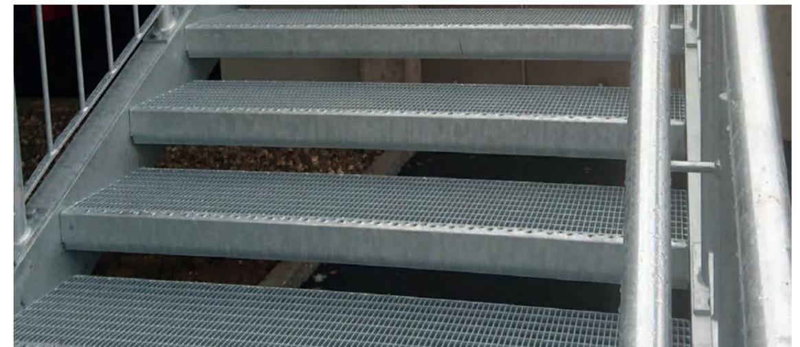
**Pressroste** werden für Bühnen, Laufstege, Regalanlagen, Podeste und Kellerschächte gebraucht. Darüber hinaus gibt es Bereiche, in denen Architektur und Ästhetik im Vordergrund stehen. Bei gleich großen Gitterrosten ist gewährleistet, dass die Trag- beziehungsweise Querstäbe fluchten.
