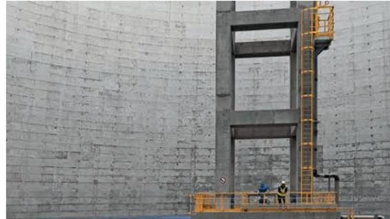
Die GFK-Steigleitern zeichnen sich neben der Witterungsbeständigkeit und einer langen Lebensdauer auch durch ein geringes Eigengewicht aus. Sie werden aus GFK-Profilen gemäß EN 13706, Typ E23 hergestellt. Das Profil ist als Sprossenprofil rutschhemmend ausgeführt. Im Verschraubungsbereich wird die GFK-Steigleiter durch PE-Materialien verstärkt.
