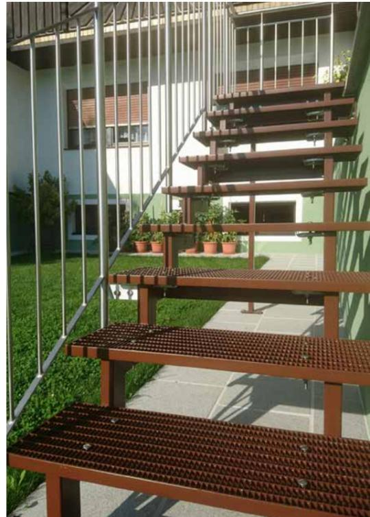
Natürlich denkt man im Zusammenhang mit dem Garten oft an eine rustikale Holztreppenkonstruktion. Aber gerade unter Umweltgesichtspunkten und sicherheitstechnischen Aspekten sollte man hier den Einbau einer Stahltreppe in Erwägung ziehen.
