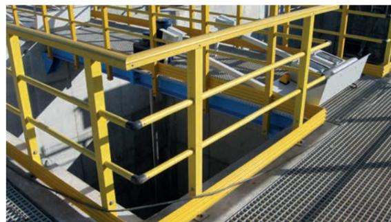
Das GFK-Geländersystem wird aus glasfaserverstärkten Kunststoffprofilen hergestellt. Es kann hohe Lasten aufnehmen, ist witterungsbeständig und sehr leicht. Es kann sowohl als horizontales als auch als Treppengeländersystem verwendet werden.
